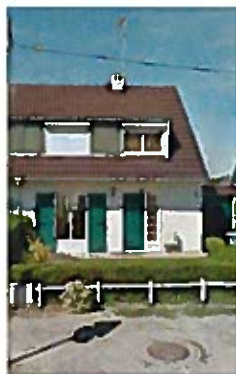
▶ Avant rénovation énergétique
